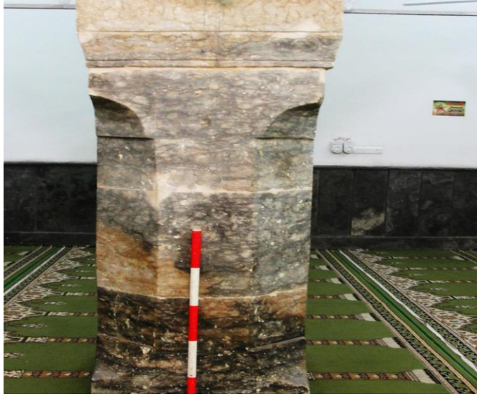
لوح (١) أحد الأكتاف المثلثة التي تحمل العقود الحاملة للقبة
