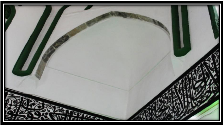
لوح (٦): إحدى الحنايا الركنية للتحويل القاعدة المربعة إلى
