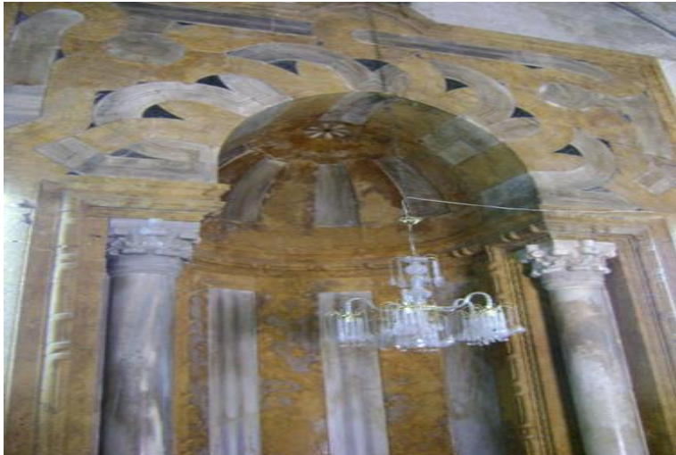
واجهة المدرسة الشاذبختية
