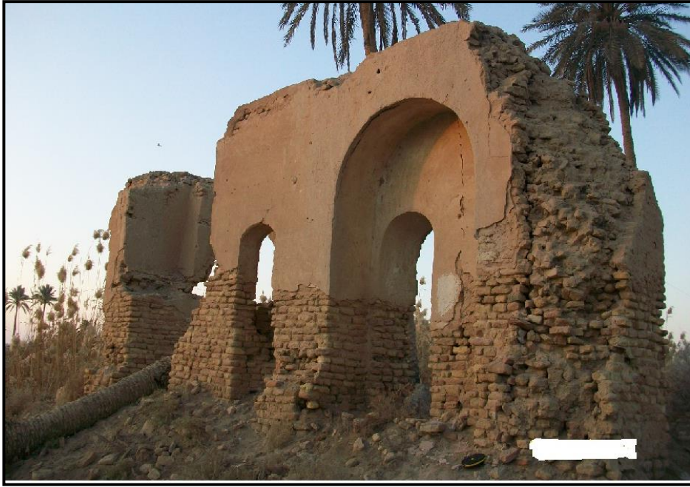
(الصورة - ٥) جدار المؤخرة، طريقة البناء بالآجر واللين ٢٩.١.٢٠١٢
