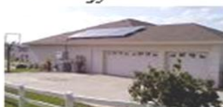
تغذية وحدة سكنية
